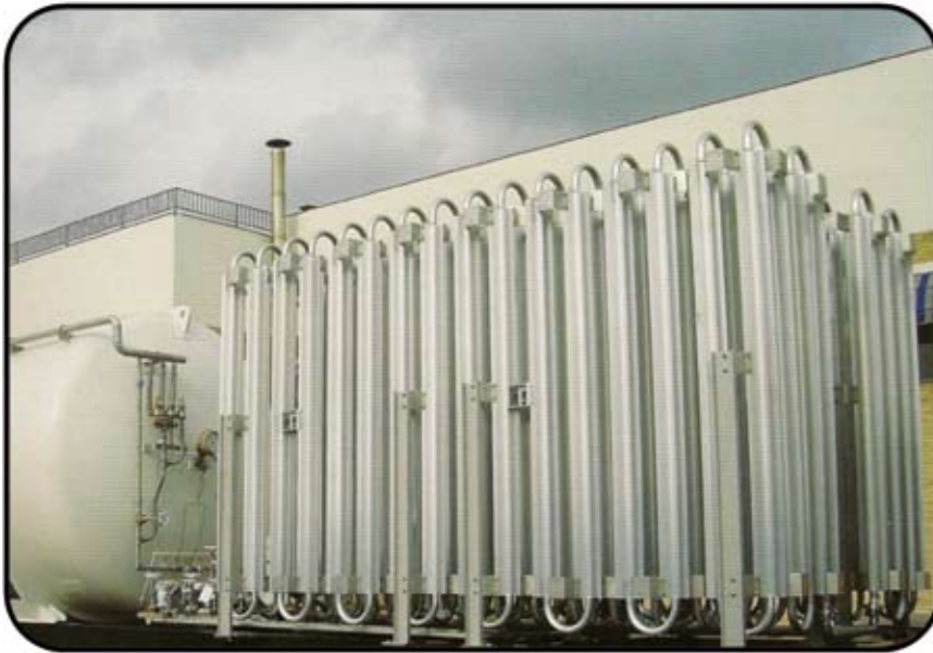
Afbeelding 17: Luchtgekoelde verdamer.
